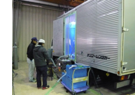
機器除染 (現地に仮設チャンパー設置)
